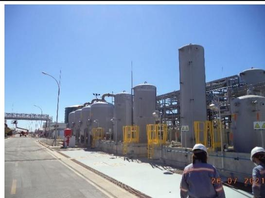
**Foto 36:** Vista do sistema de tratamento para dessalinização e desmineralização da água salgada captada.
