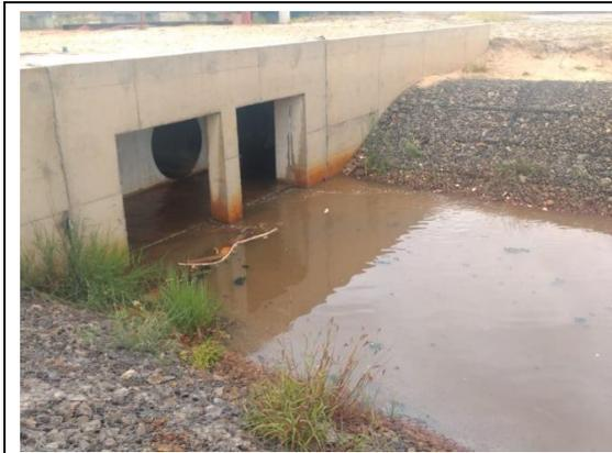
**Foto 17:** Acúmulo de microlixo na saída da tubulação da macrodrenagem próximo a entrada do canal.
