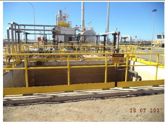
**Foto 45:** Vista do tanque de neutralização da ETE para tratamento da água industrial.
