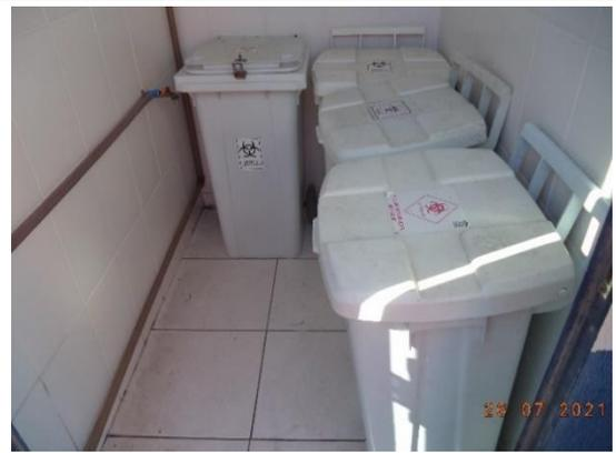
**Foto 51:** Baia de deposição de resíduos de saúde. Os resíduos são depositados em sacos e coletores brancos identificados. O local possui piso e chão laváveis e drenagem que direciona os efluentes da lavagem para a ETE.
