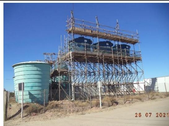
**Foto 37:** Vista das caixas d'água no canteiro de obras, para armazenamento de água potável.
