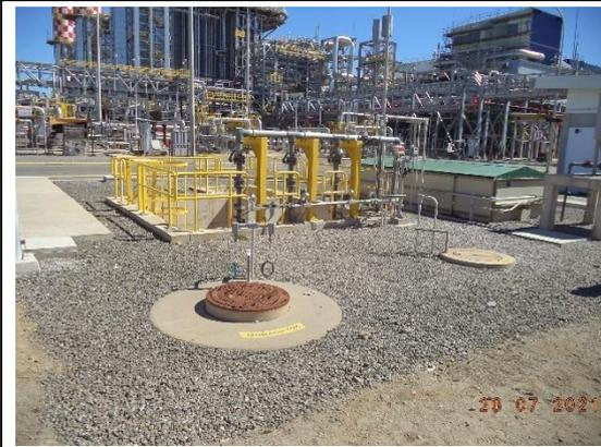
**Foto 44:** ETE existente na UTE GNA I que conta com caixa de decantação e tanque de neutralização.
