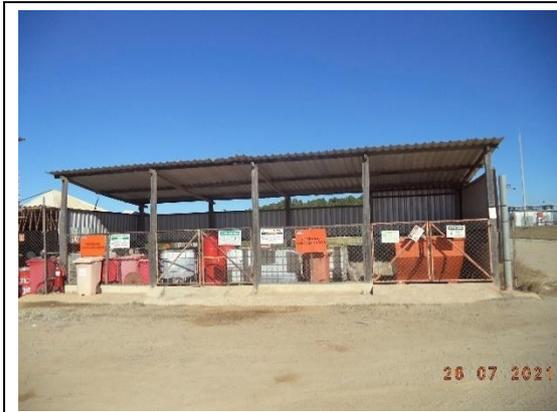
**Foto 54:** Central de resíduos perigosos no canteiro avançado. O local encontra-se isolado, identificado, ventilado, protegido contra intempéries, e ligado a caixa de contenção para o caso de vazamentos.
