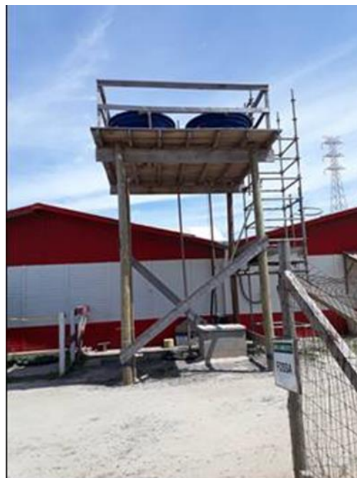
Figura 19 - Sistema de armazenamento de água potável no canteiro de obras. Fonte: MRS Ambiental, 2020.
