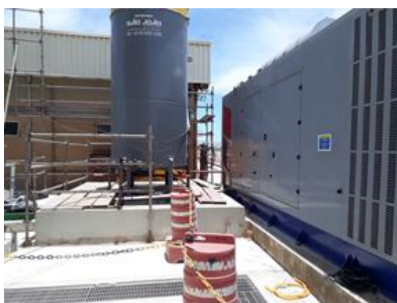
Figura 22 - Geradores de eletricidade de emergência e suporte (backup), em construção. Fonte: MRS Ambiental, 2020.
