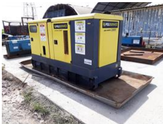
Figura 20 - Gerador movido a ciclo diesel e bandeja de contenção. Fonte: MRS Ambiental, 2020.
