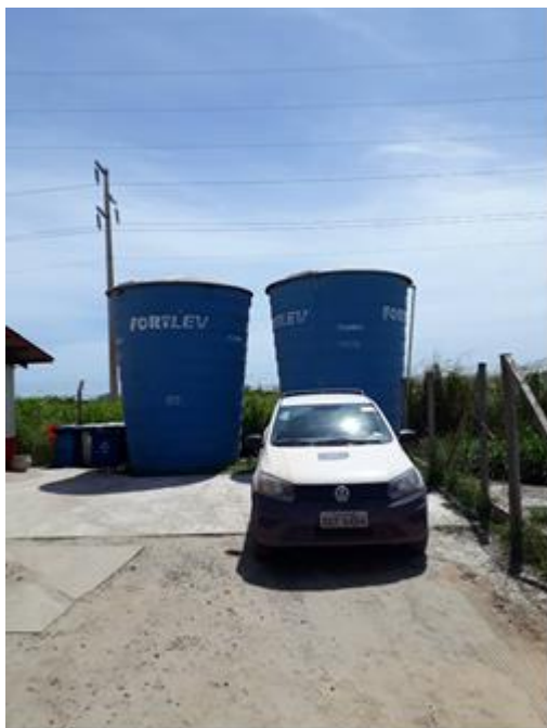
Figura 19 - Sistema de armazenamento de água potável no canteiro de obras. Fonte: MRS Ambiental, 2020.
