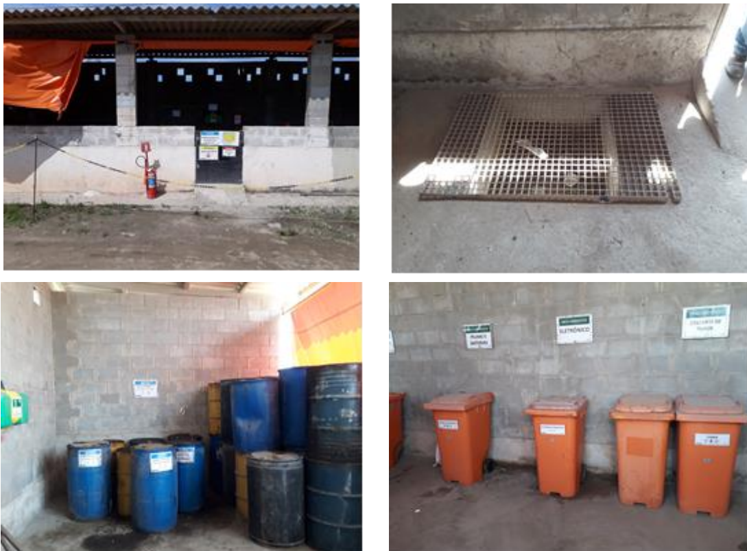
Figura 31 - Central de Resíduos do Canteiro de Obras. Fonte: MRS Ambiental, 2020.
