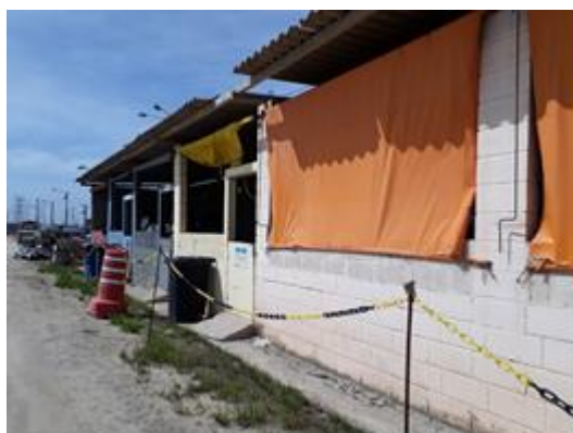
Figura 11 – Ausência de controle de roedores no entorno da Central de Resíduos. Fonte: MRS Ambiental, 2020.
