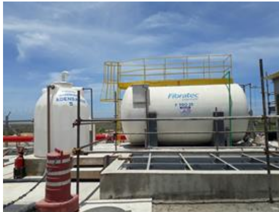
Figura 26 - ETE em construção no prédio administrativo do TGNL. Fonte: MRS Ambiental, 2020.
