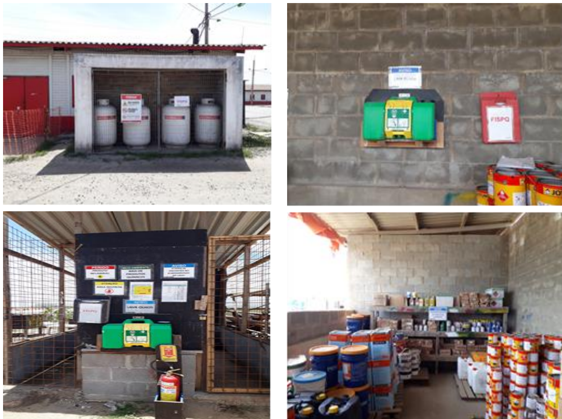
Figura 23 - Armazenamento de produtos químicos e gases nos canteiros da Acciona Industrial. Fonte: MRS Ambiental, 2020.
