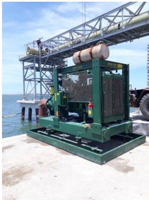
Figura 25 - Bomba de sucção para captação da água do mar locada na borda da plataforma. Fonte: MRS Ambiental, 2020.
