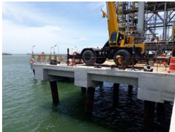
Figura 29 - Presença de mureta no dolphin principal em construção. Fonte: MRS Ambiental, 2020.
