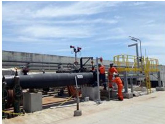
Figura 15 - Flanges e válvulas no duto para transporte de gás. Fonte: MRS Ambiental, 2020.
