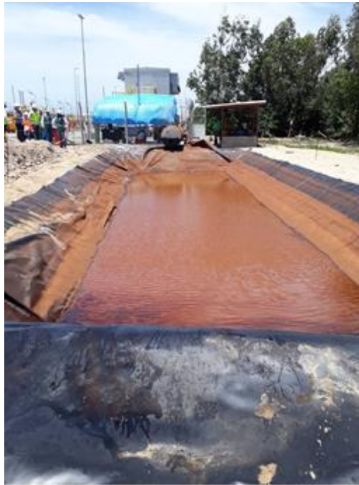
Figura 18 - Tanque de decantação e armazenamento temporário do efluente gerado no TH. Fonte: MRS Ambiental, 2020.
