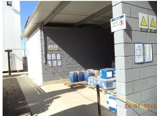
**Foto 08:** Depósito de produtos químicos isolado, sinalizado, ventilado, coberto, interligado ao sistema de contenção para efluentes oleosos e com as devidas FISPQs.
