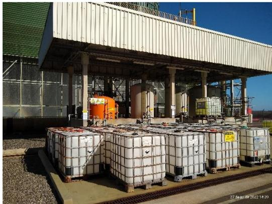
**Foto 27:** Contêineres IBC vazios (apenas hipoclorito de sódio residual) depositados em área próxima à Torre de Resfriamento.
