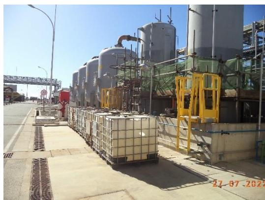
**Foto 06:** Vista do sistema de tratamento para dessalinização e desmineralização da água salgada captada.
