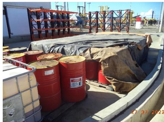
**Foto 30:** Embora o local possua contenção, a mesma não está ligada ao sistema de drenagem oleosa, o que faz com que, em caso de vazamentos, o líquido necessite ser escoado adequadamente.
