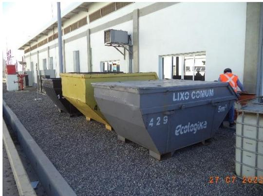
**Foto 15:** Área de transbordo de resíduos instalada na GNA I. O local não possui contenção, cobertura e isolamento.
