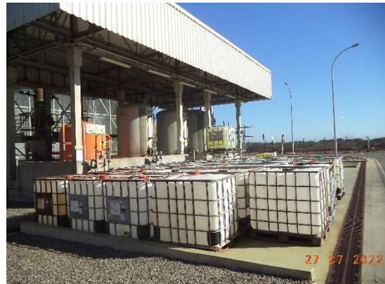
**Foto 10:** Depósito de contenedores com hipoclorito de sódio residual. O local não possui cobertura.
