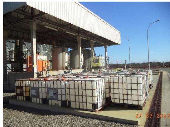
**Foto 12:** Canaleta do sistema de drenagem oleosa.
